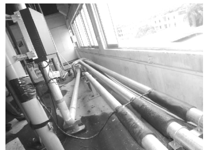
图8 电磁感应水处理系统
