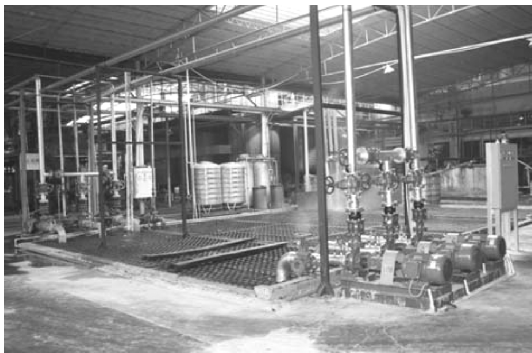
图2 循环用水系统的六组抽水泵，可按冷却用水量分别自动控制。
